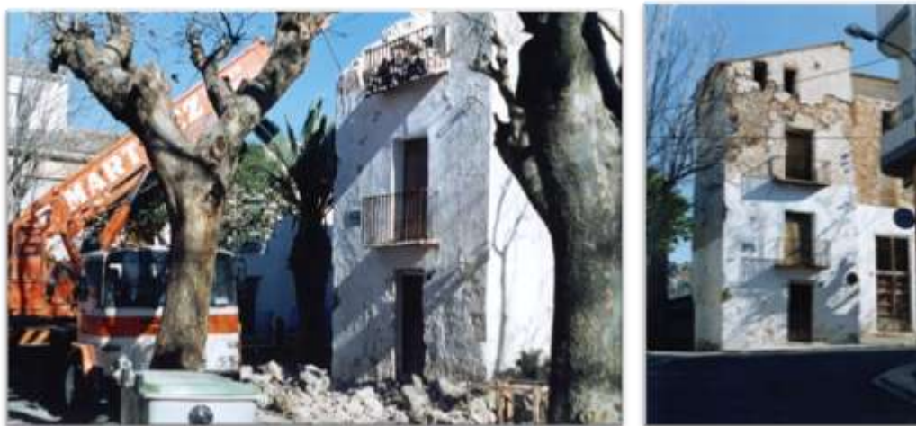
Obras de derribo del Palacio de la Alameda. Archivo José Izquierdo
