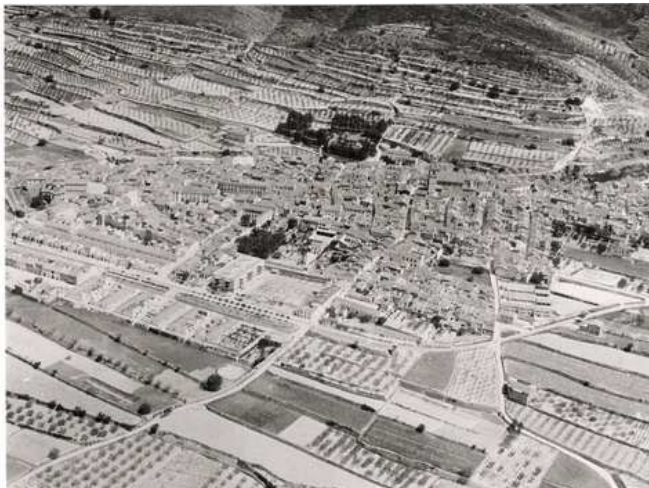
Caminos del Vapor y de san Antón (Vista aérea)
